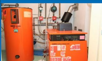
**Ölheizkessel Leistung 20kW**
